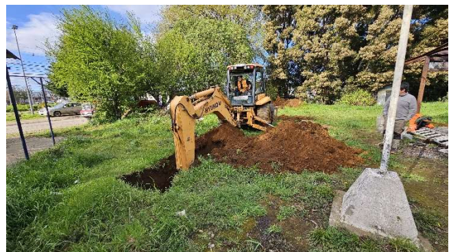
Figura 2.5: Ejecución de calicata C-4.
