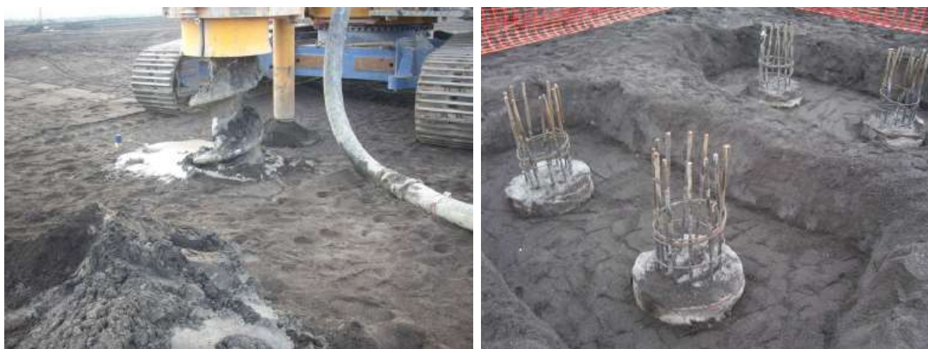
Figura 8.2: Ejecución en terreno de pilote CFA (tomado de Terratest)
