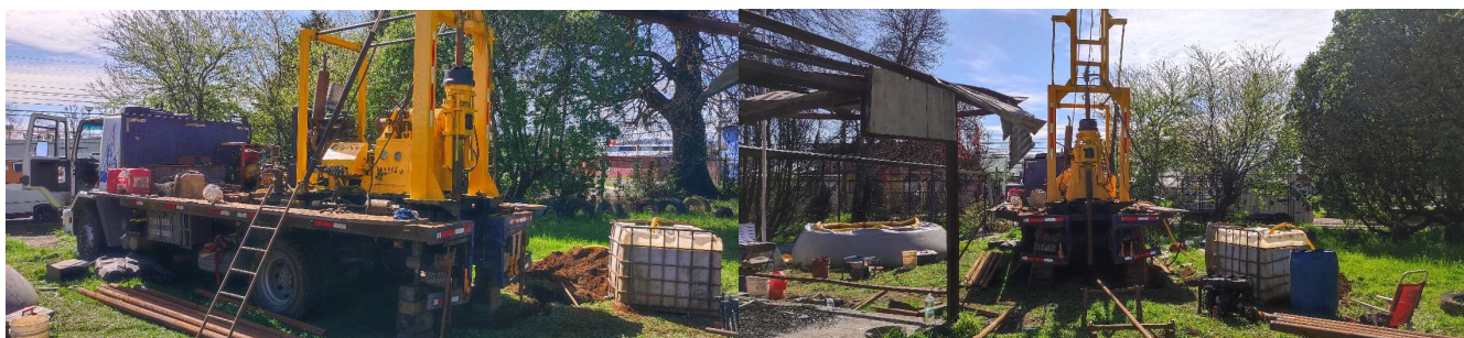
Figura 2.7: Sondaje 30 m de profundidad.
