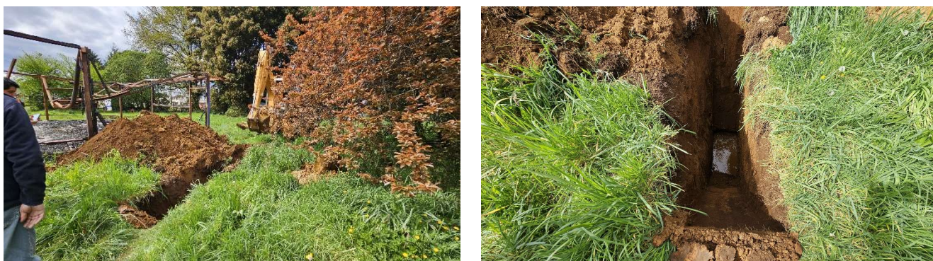
Figura 2.2: Ejecución de calicata C-1.
