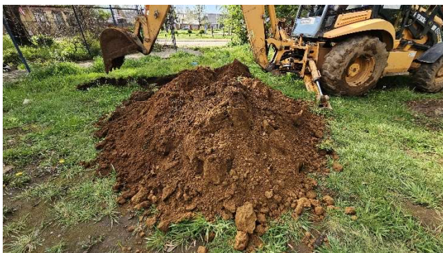
Figura 2.5: Ejecución de calicata C-4.
