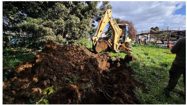
Figura 2.4: Ejecución de calicata C-3.
