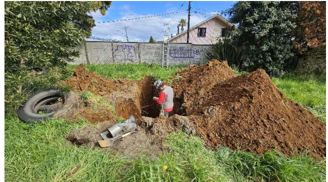
Figura 2.3: Ejecución de calicata C-2.
